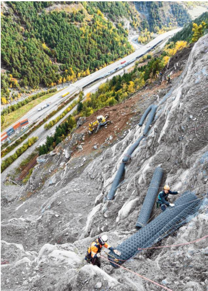
Aanbrengen van netten op het middelste deel van de klif. FOTO DÉPARTEMENT SAVOIE
