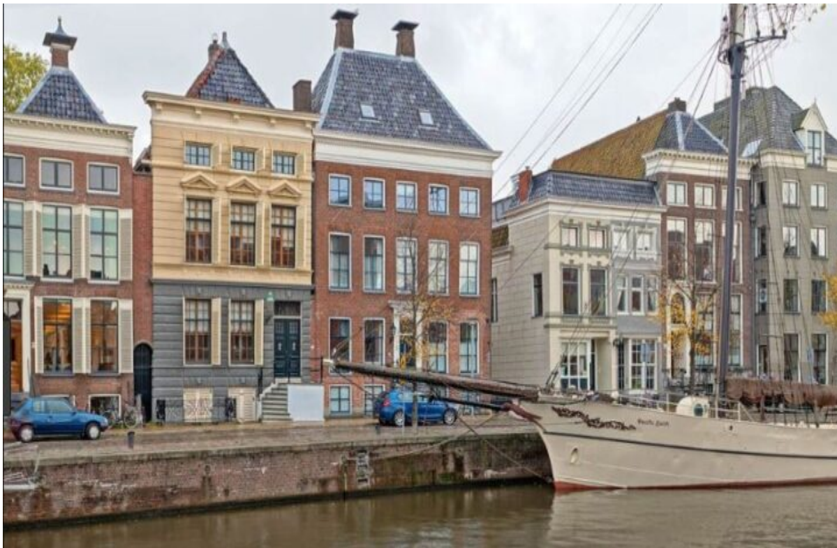
Herenhuizen aan de Hoge der A
