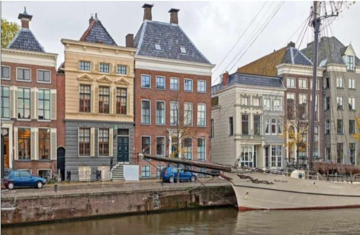
Herenhuizen aan de Hoge der A
